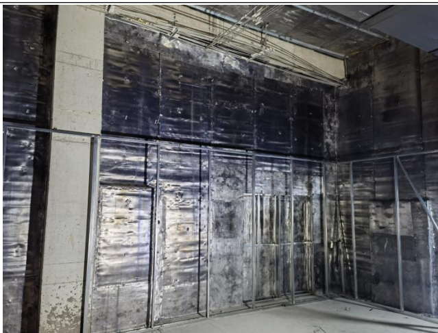
DSA机房墙体、顶板铅板安装现场照片
