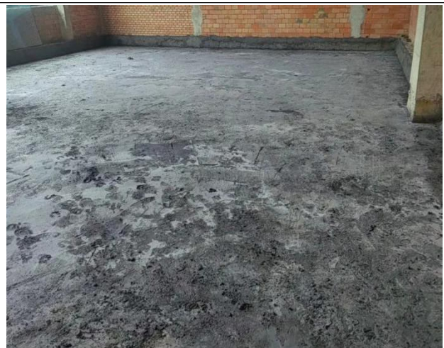
DSA机房地面硫酸钡水泥敷设现场照片
